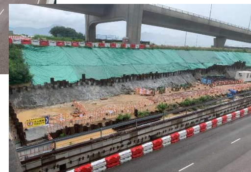
臨時支撐工程及建造擋土牆工程
