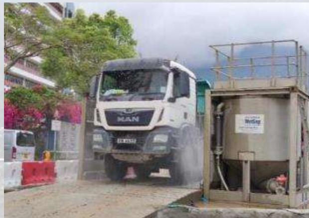
地盤出口設立洗車設施
