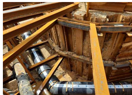
敷設污水壓力管道
