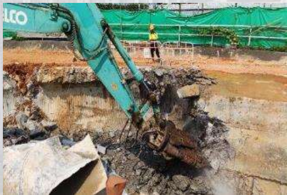
使用靜音設備進行拆卸工程
