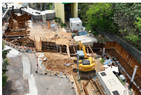
敷設污水壓力管道
