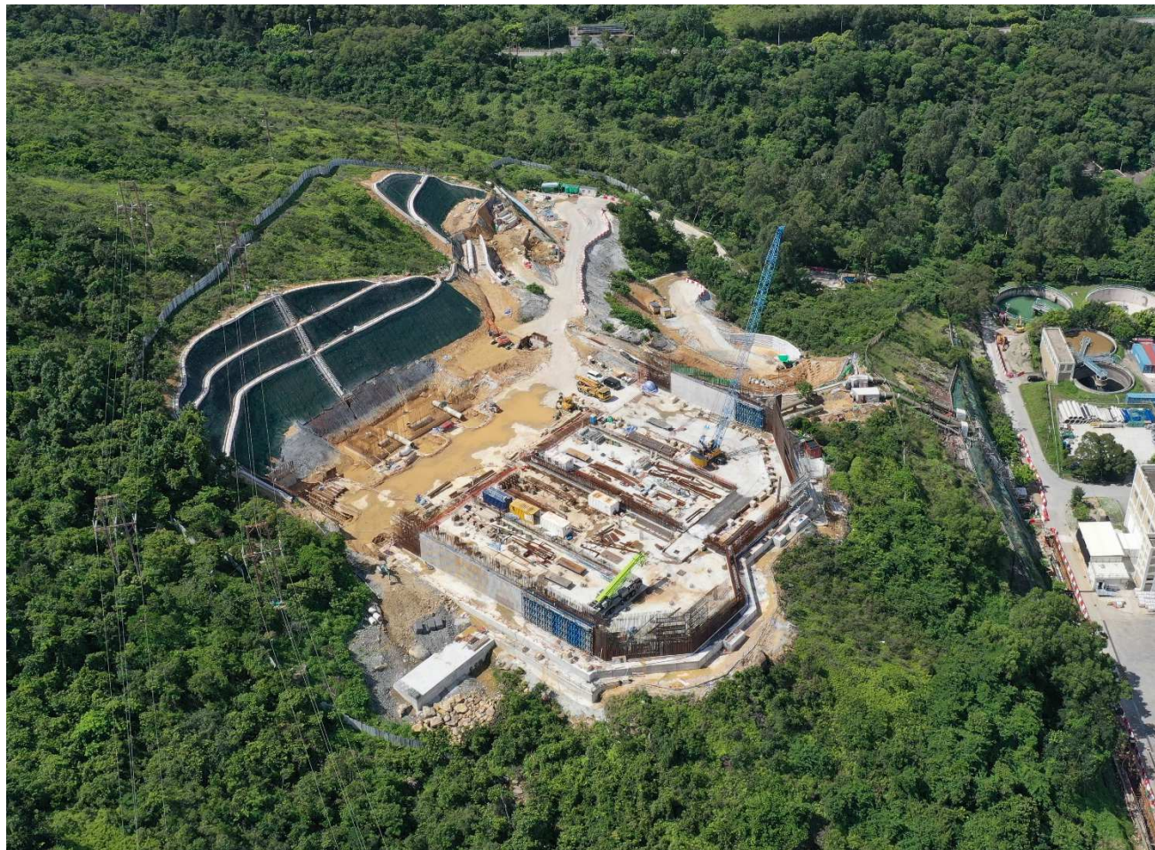
斜坡平整和建造食水配水庫
