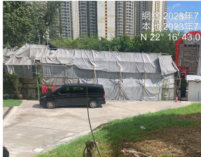
水平定向鑽挖
