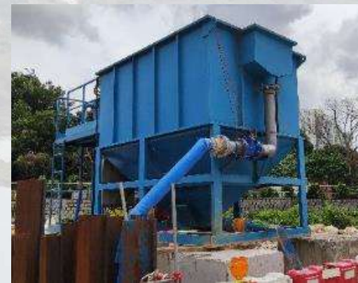
設置污水處理設施
