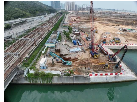
隧道改建相關工程
