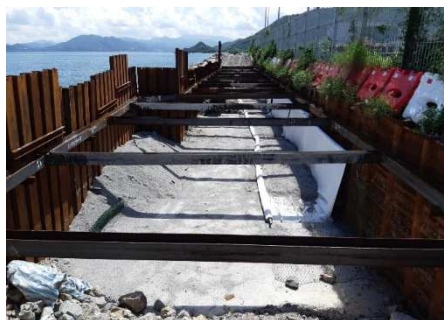
敷設食水輸水管及污水壓力管道
